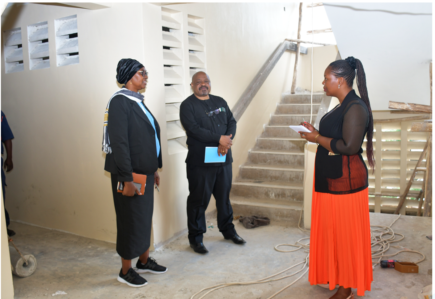
Naibu Katibu Mkuu Wizara ya Maji, Mhandisi Nadhifa Kemikimba akikagua ukarabati wa Hostel Block F.
